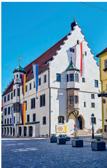
Das „Steinhaus zu Nördlingen“ ist seit nunmehr über 600 Jahren das Rathaus der Stadt.
