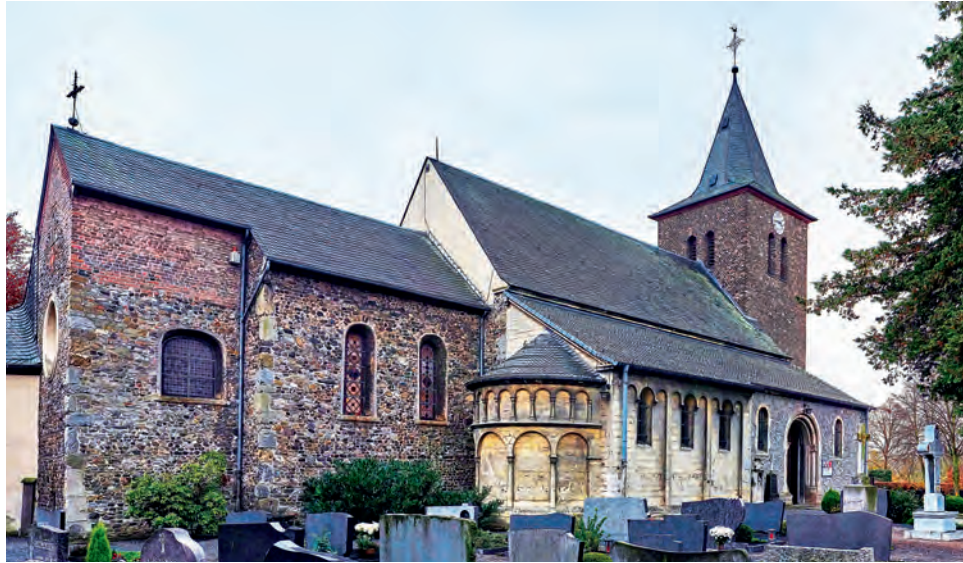
Die wichtigste Herrschaft des Selfkants im Mittelalter war zunächst Millen, der Sitz des Geschlechts der Herren von Millen. Noch heute zeigt die Außenseite der Millener Kirche drei verschiedenen Mauerwerke aus unterschiedlichen Jahrhunderten.
