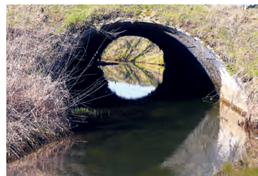
Die Hunte im alten Betonbett ...
